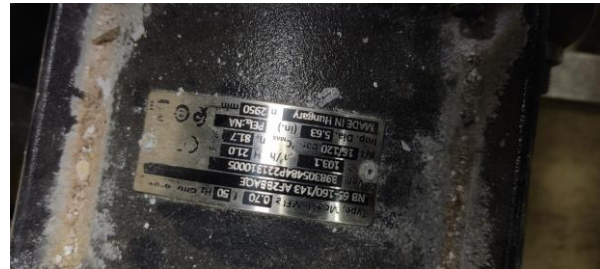
Beltéri úszó – Grundfos NB 65-160/143 adattábla.
